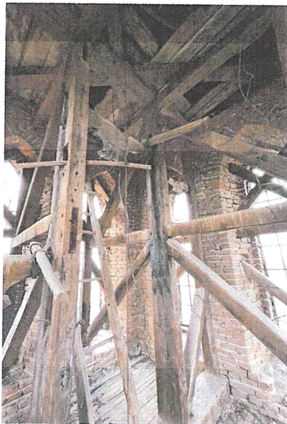
Fot.3 Wieża - drewniana konstrukcja wieży poniżej podstawy helmu
