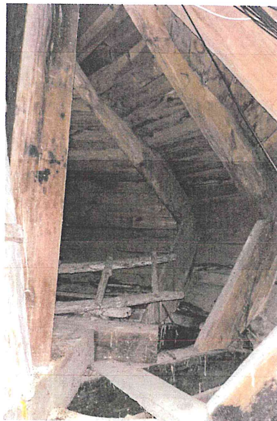
Fot.2 Wieża - drewniana konstrukcja podstawy helmu
