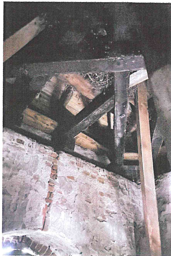
Fot.4 Wieża - drewniana konstrukcja podstawy helmu
